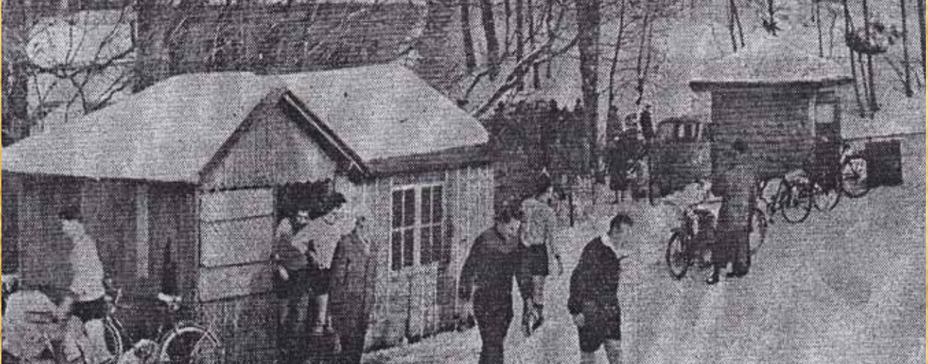
Spieler und Schiedsrichter kommen gerade aus der Behelfsbaracke heraus. Ganz rechts das ehemalige Kassenhäuschen, welches noch heute steht.
